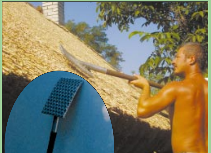
Henk ütő (tömörítésre szolgáló szerszám) és annak használata a tető felújítása során
